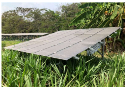
ภาพที่ 2 แผงเซลล์แสงอาทิตย์ชนิด Amorphous Silicon ขนาด 94 วัตต์ (Calyxo) จำนวน 18 แผง (ต่อแบบผสม โดยต่ออนุกรม 6 แผง แล้วต่อขนานกัน 3 ชุด)
