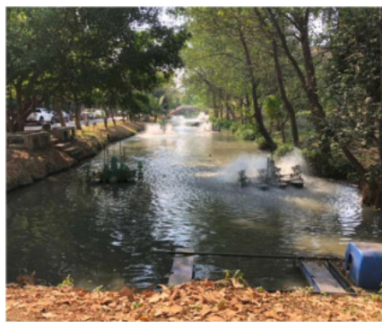
ภาพที่ 1 ตัวอย่างคลองน้ำที่ใช้ระบบการเติมออกซิเจนด้วยกังหันน้ำ (พื้นที่มหาวิทยาลัยกรุงเทพธนบุรี จ.กรุงเทพมหานคร)
